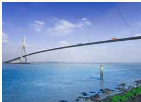
Die größte Schrägseilbrücke Europas
